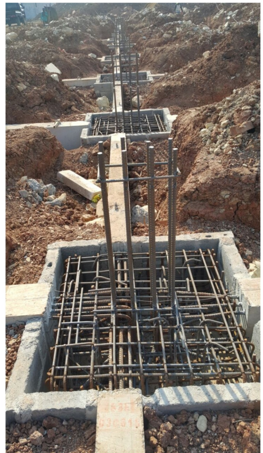
Rangka Pile Cap
