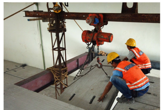
1. Dengan menggunakan HOIST
