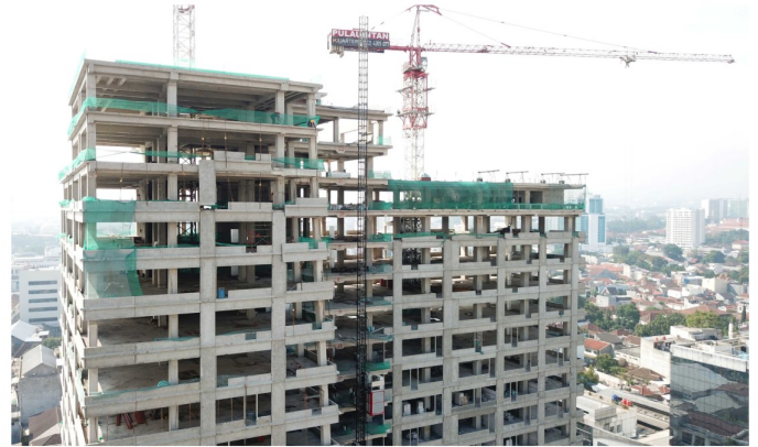
2. Pengangkatan menggunakan tower crane
