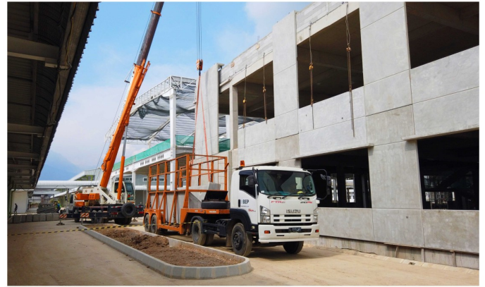
1. Pengangkatan menggunakan mobil crane
